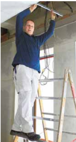
Markus Schwanz kontrolliert auf der Baustelle in der August-Ruf-Straße, ob seine Mitarbeiter beim Einsetzen der Decke alles richtig gemacht haben. BILD: KNOCH
