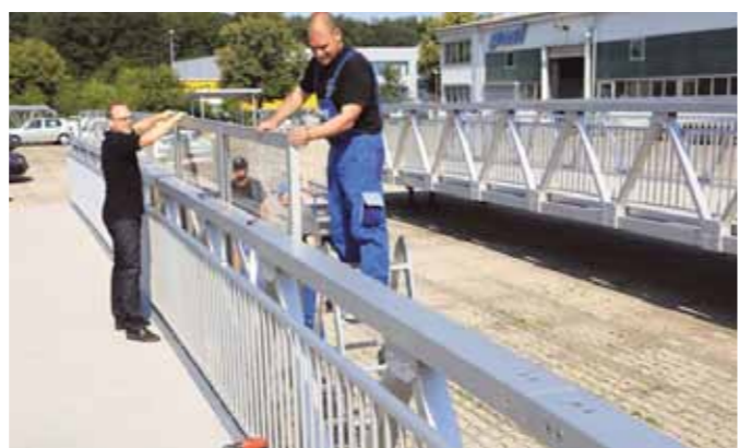
Hier montieren Stefan Heth (links), 40, Projektleiter und Georg Hinze, 26 (rechts), Montageleiter, beide zuständig für den Bereich Brückenbau, den Berufsschutz der neuen, aus zwei Teilen bestehenden Fuß- und Radbrücke, die Mitte August in Friedrichsthal/Saar installiert wird. Die „Bismarckbrücke“, so der Name des neuen Bauwerks, überbrückt eine Batmlinie. Deshalb ist der Berufsschutz erforderlich. Er verhindert, dass Passanten die elektrischen Leitungen berühren können. BILD: R. TESCH
