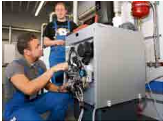
Benjamin Reinbold (links) und Florian Maier, beide Azubis im dritten Lehrjahr, trainieren hier die Inbetriebnahme einer Wärmeerzeugungsanlage. Zwölf hochmoderne Kesselanlagen stehen dafür in der Werkstatt für Sanitär-, Heizung- und Klimatechnik in der Bildungsakademie zur Verfügung.
